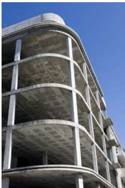
Figur 7 - Bæresystem i betong (NorgesBIM, 2019)
