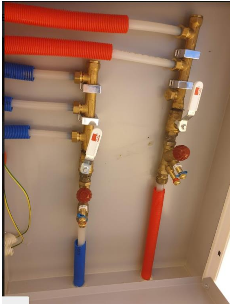
Figur 10 TA-ventiler montert i fordelerskap for badrom.
