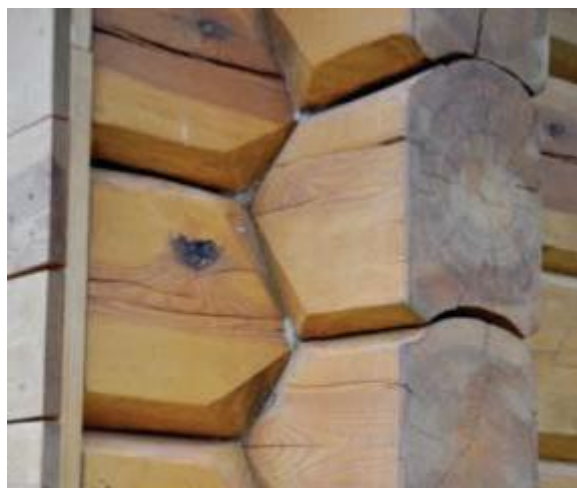
Figur 11: Kvarkenov med kinninger (Edvardsen, 2017) Figur 12: Kvarkenov med kinninger (Alve, Uus, Teder, Miljan og Kalamees, 2014)
