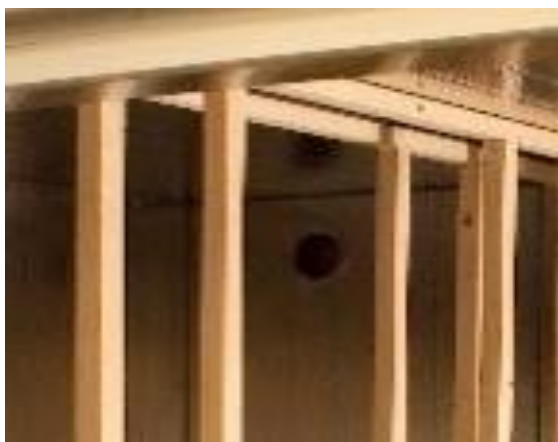
Figur 53: Ventil ut av klimarom, varm side
