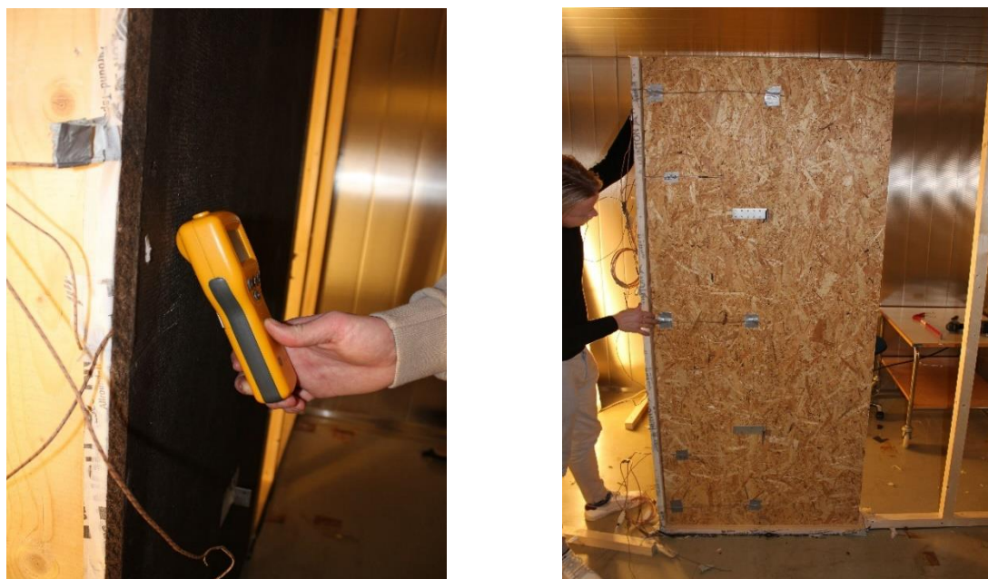
Figur 33: Til venstre: Resistansmåler med ca. 20 graders vinkel på asfaltplaten, Til høyre: Samme metode ble brukt på OSB-platen
