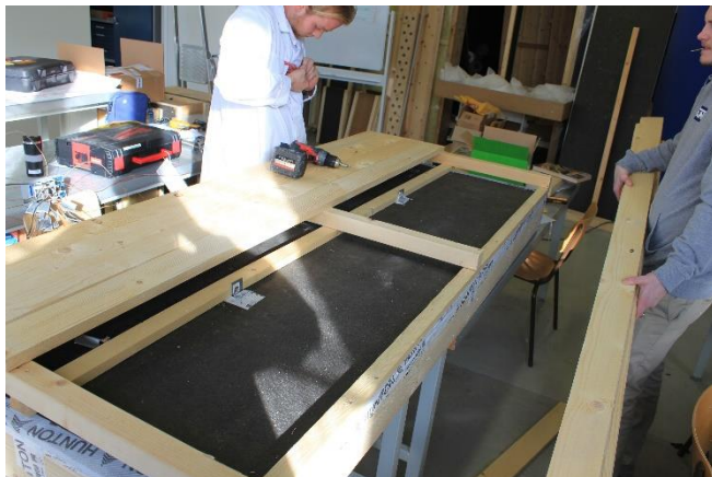
Figur 32: Montering av utvendig kledning
