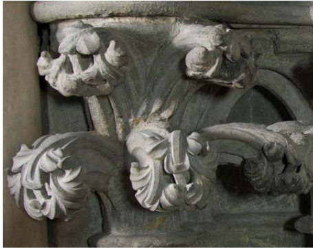
Figur 10 Kleristoriet Oktogon, tidlig 1200-tallet (delvis restaurert)
