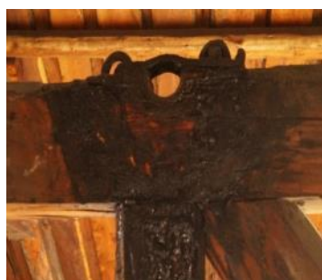
Bilde 23 Foto til venstre og midt; rester etter heiseanordning mot gaten. Foto til høyre; Bemerk uttakene i svill, vegg og stolpe angivelig fra tidligere heiseanordning mot elven.
