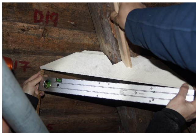
Bilde 19 Hjelpemal for måling av kanten på gratsperret.
