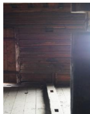
Bilde 23 Foto til venstre og midt; rester etter heiseanordning mot gaten. Foto til høyre; Bemerk uttakene i svill, vegg og stolpe angivelig fra tidligere heiseanordning mot elven.
