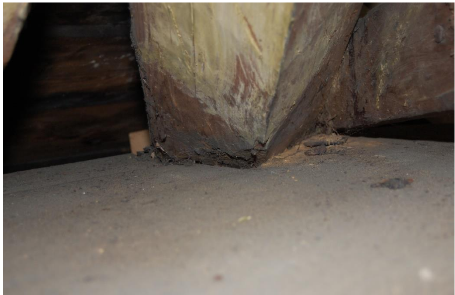
Bilde 47 Gratsperre S (sør)
