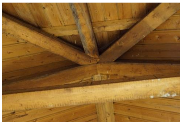
Bilde 90 Loddstilt Gratsperre med midtskifter
