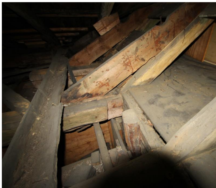
Bilde 43 Rester av eldre takrenne
