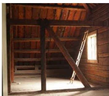
Bilde 23 Foto til venstre og midt; rester etter heiseanordning mot gaten. Foto til høyre; Bemerk uttakene i svill, vegg og stolpe angivelig fra tidligere heiseanordning mot elven.
