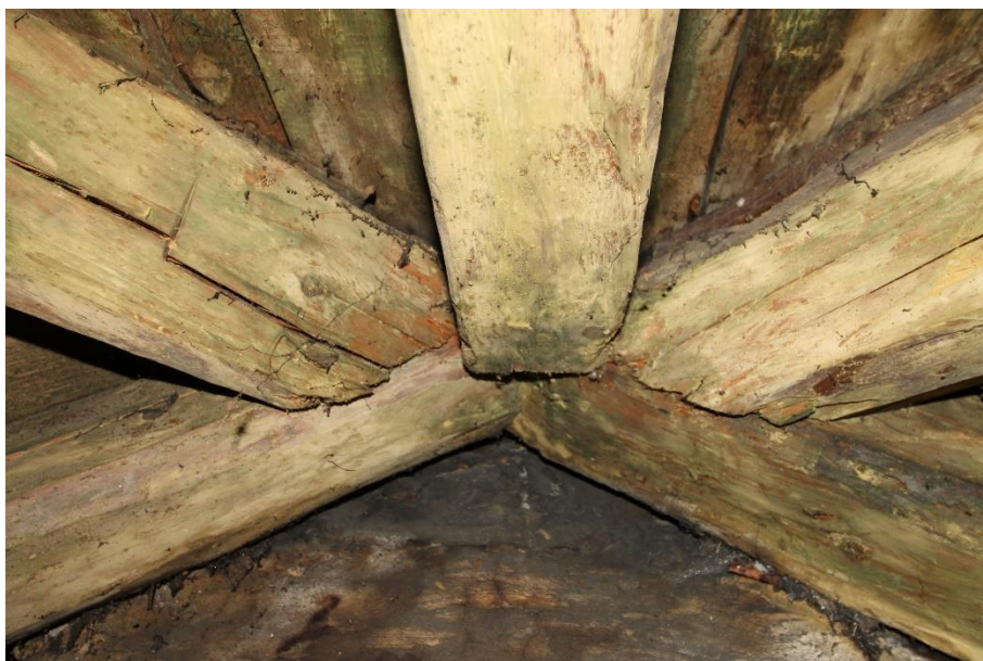
Bilde 54 Mønepunkt med midtsperre mot anleggsbindet.
