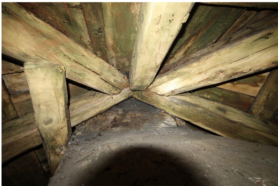
Bilde 53 Midtsperret i nord-vest sett fra undersiden, med skorsteinen rett fremfor
