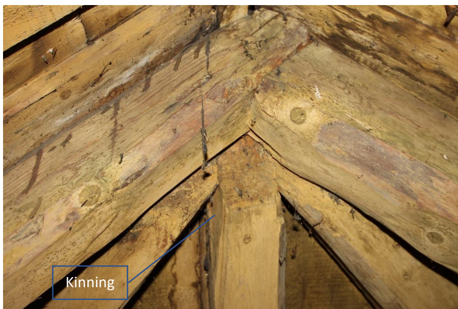
Bilde 51 Kinningsperre mellom gratsperrene i sør-øst.
