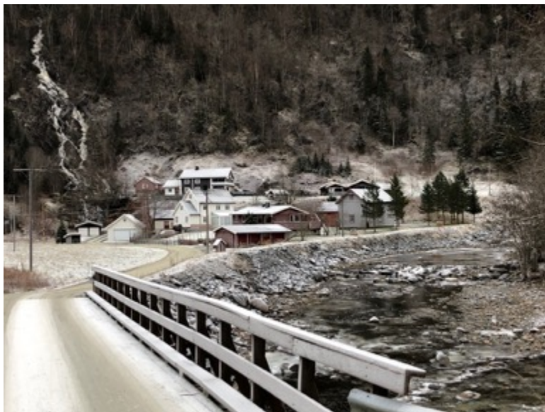
Figur 4: Opparbeidet jordvoll langs elvekanten. Kilnesbekken er nedfrosset i dalsiden oppe til venstre.
