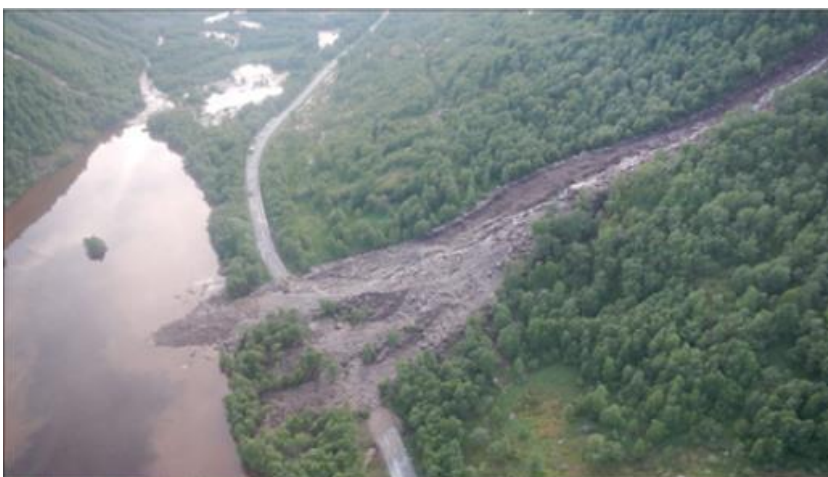
Figur 3.6: Flomskred ved Mjåland i Gjesdal i Rogaland i 2016 (Staten vegvesen, 2011).
