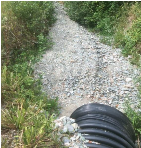
Figur 6.14: (a) Eksempelet viser at sedimenter har blitt transportert gjennom stikkrennen og avsatt ved utløpet. (b) Eksempelet viser at sedimenter har blitt avsatt ved innløpet til stikkrennen (Vatne, 2018ab).
