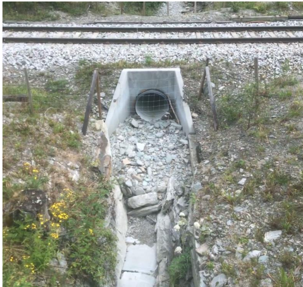
Figur 6.14: (a) Eksempelet viser at sedimenter har blitt transportert gjennom stikkrennen og avsatt ved utløpet. (b) Eksempelet viser at sedimenter har blitt avsatt ved innløpet til stikkrennen (Vatne, 2018ab).
