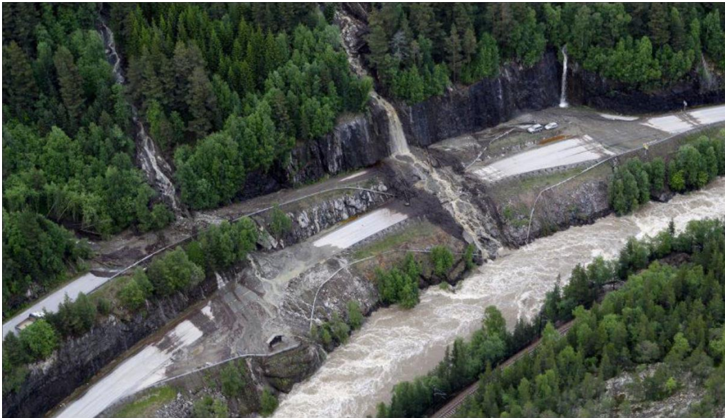
Figur 3.7: Skader på vegnettet etter vann- og løsmasser ved Høvringen i Gudbrandsdalen. Her er det vanskelig å skille hvorvidt avsetningene skyldes flomskred eller høy masseføring i elv (Scanpix, 2011a).
