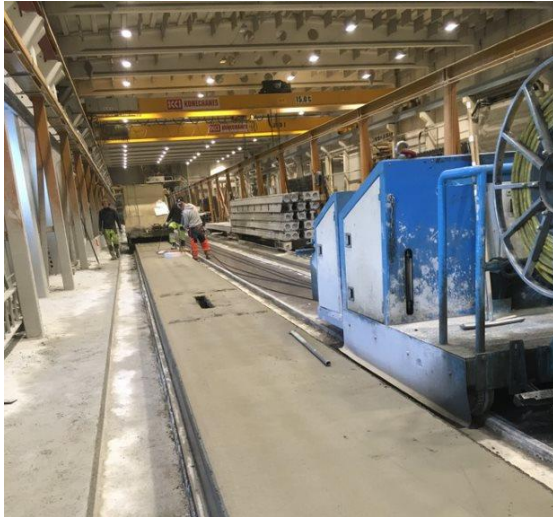
Bilde 23 - Legge betong
