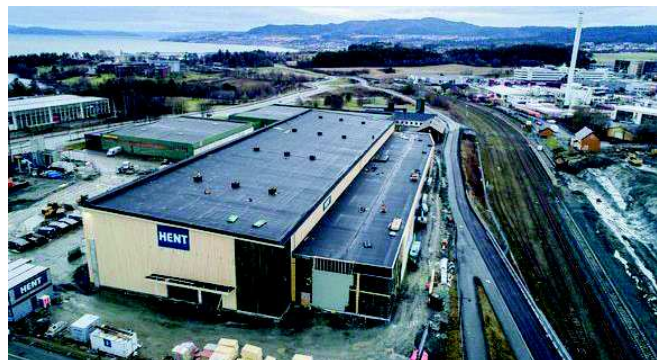
Ombygningsarbeidet i hangaren er nesten ferdig, og bygget skal stå klart sommeren 2019 (Foto: Håvard Jensen, Adresseavisen)
