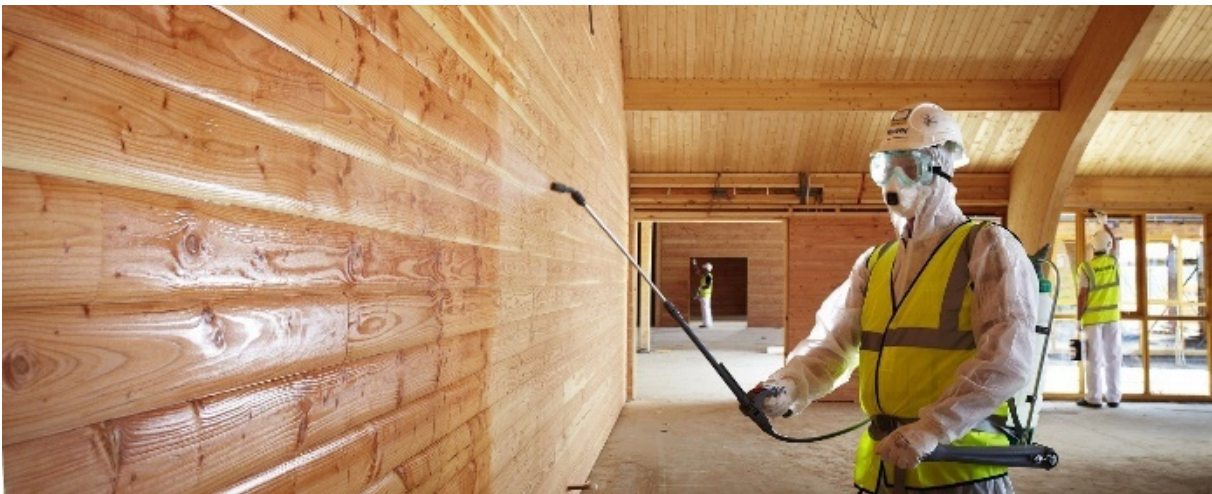
Figur 34: Påføring av brannlakk på trekledning (Foto: thermax.no)
