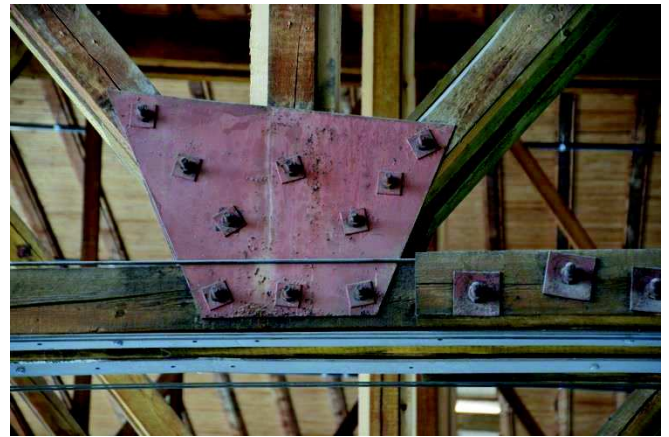
Knutepunktene i fagverkene er av stål og beskyttes med brannhemmende maling. På bildet ser man også hvordan undergurten er forsterket med stål. (Foto: Byantikvaren)
