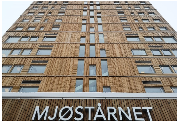
Figur 35: Mjøstårnet, verdens høyeste trebygning (Foto: Kaia Eriksen)
