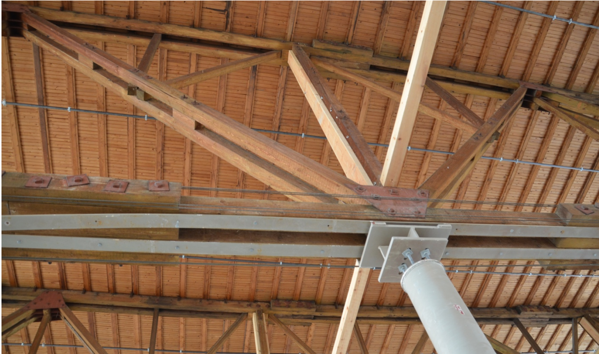
Figur 27: Forsterkninger av fagverk (Foto: Byantikvaren)
