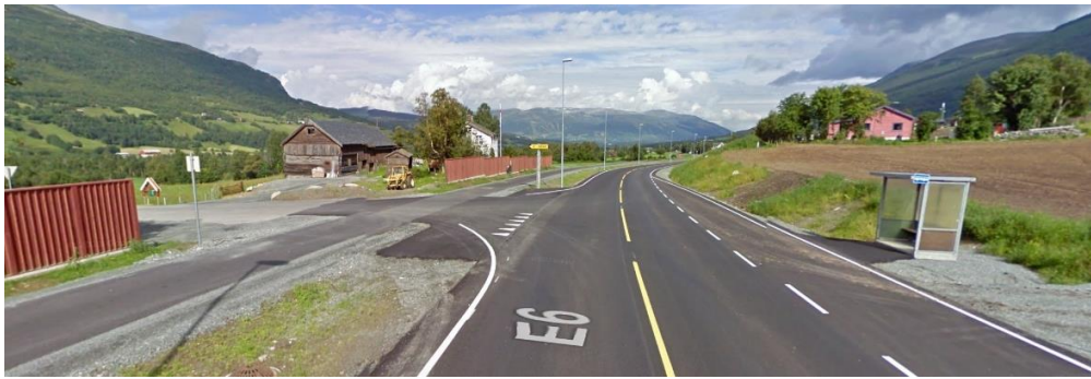
Figur 3: Krysset mellom E6 og fylkesveg 520
