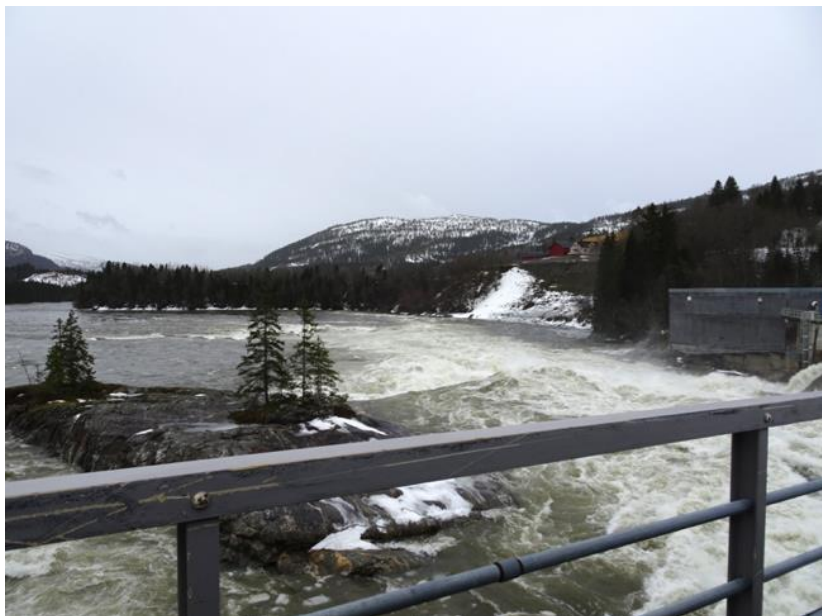
Figur 20: Utsikt sørover fra bruen ved Øvre Fiskumfoss, foto fra befarings.
