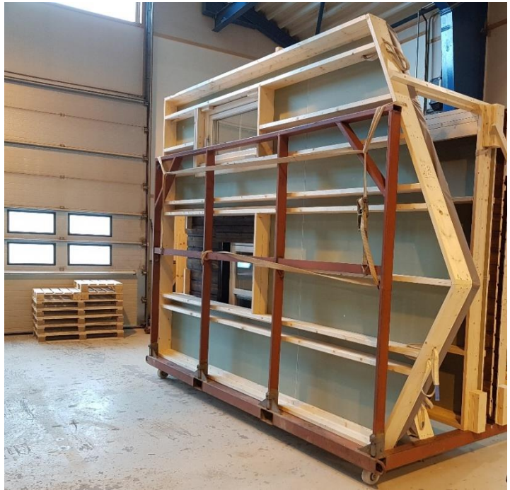
Figur 14: Ferdig element på ramme, Oppdal bygg AS
