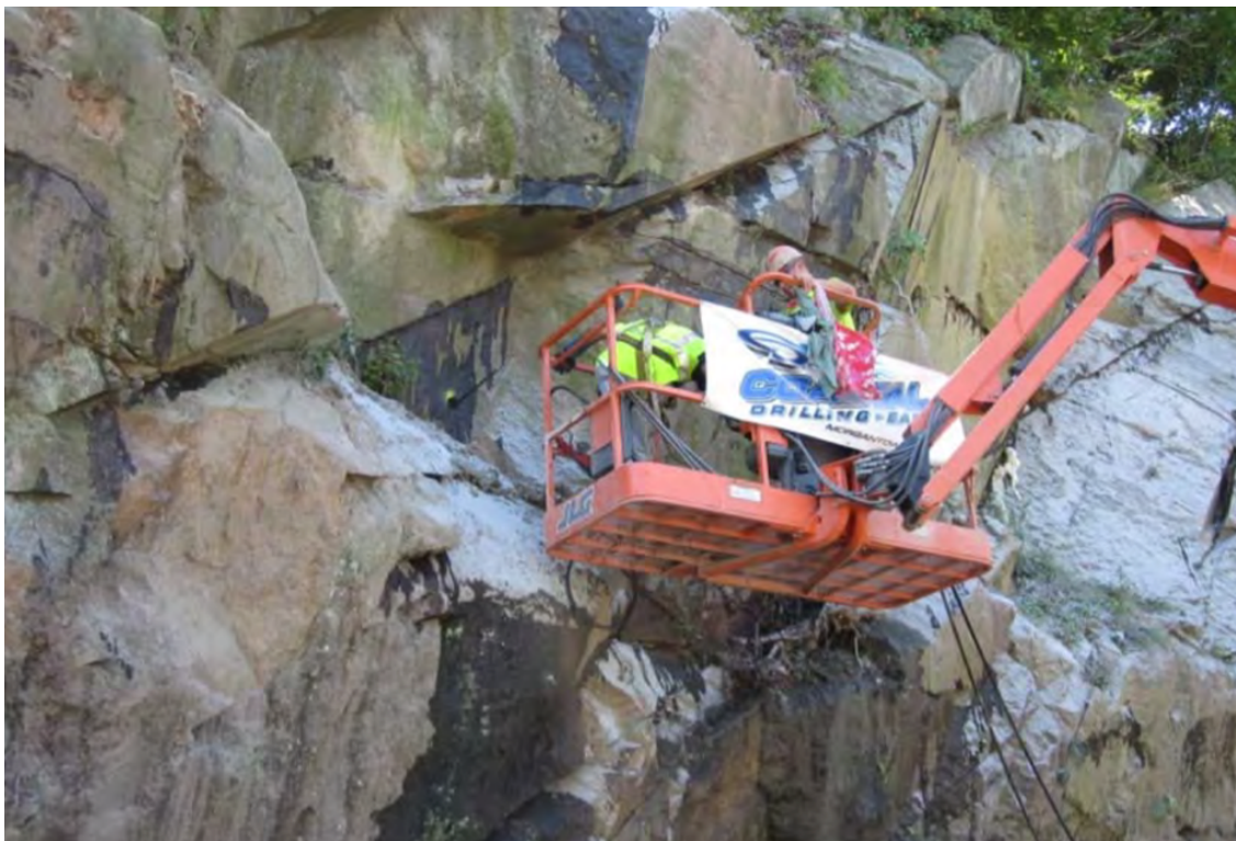
Figur 33: Eksempel bruk av injeksjon i fjellskråning. Figur: Coastal Drilling.
