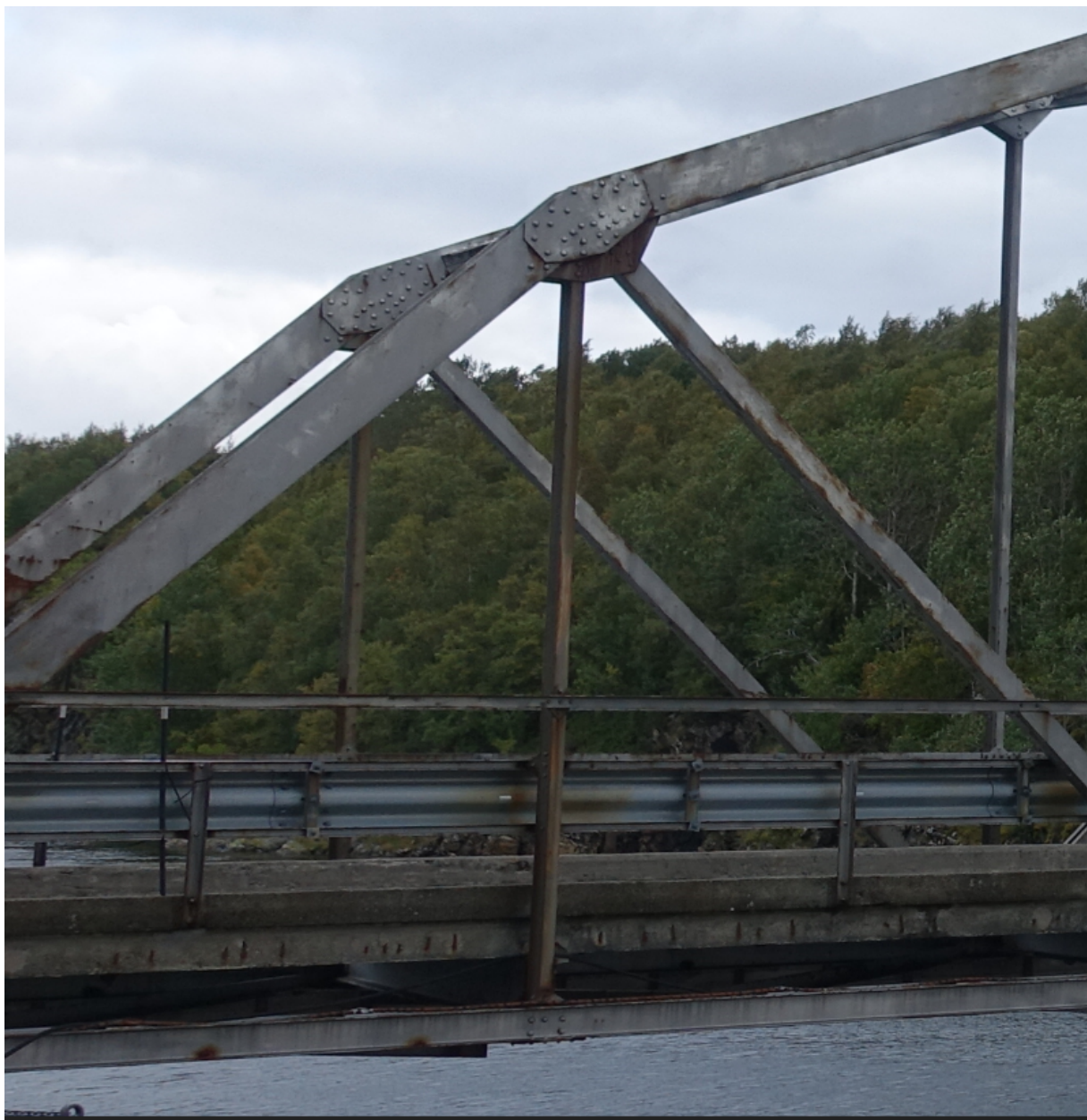
Figur 6.9: Knutepunkt 1, Bilde fra befarings
