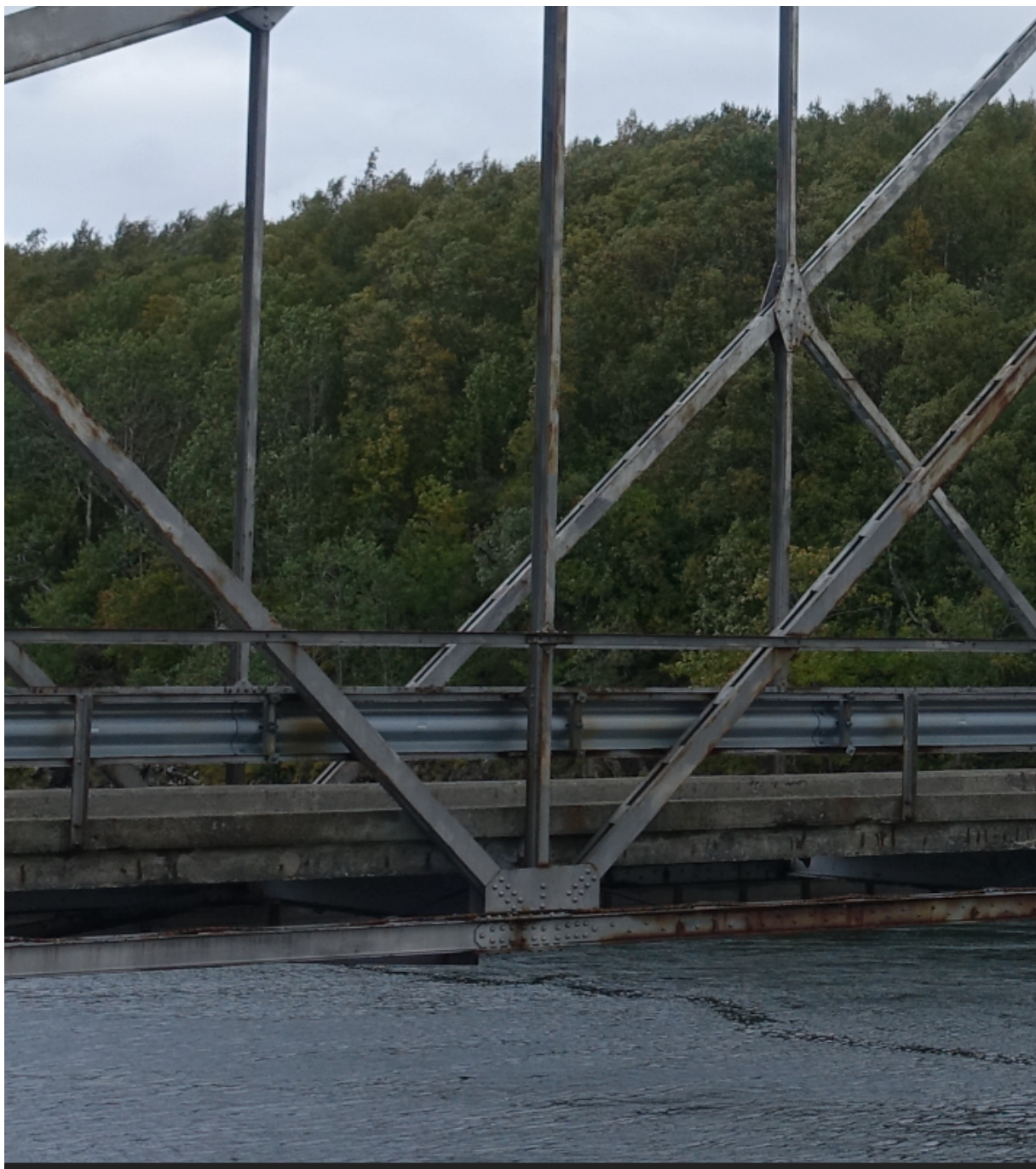
Figur 6.23: Knutepunkt 4, Bilde fra befarings
