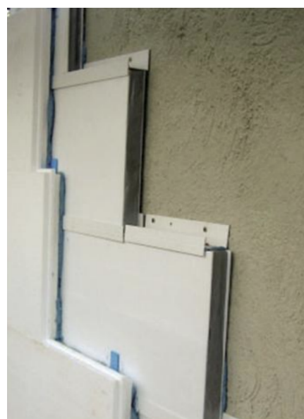
Figur 13: Skinnesystem brukt mellom VIP [18].
