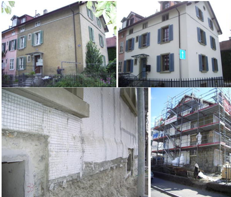
Figur 10: Boligen i Zürich. De to øverste bildene illustrerer boligen før og etter rehabilitering, mens de to nederste illustrerer ytterveggen under renoveringen med aerogelmattene [27].
