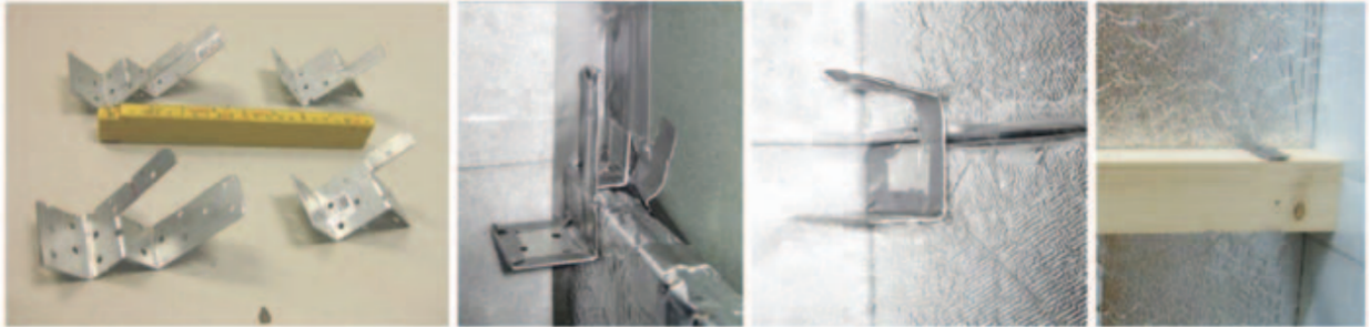
Figur 14: Stålvinkler med innfestede lekter utenpå vakuumisolasjonspaneler [49].
