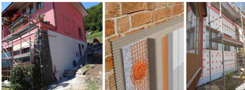
Figur 19: Rehabilitering av kjellerveggen med AEROCALCE. Bildet til venstre illustrerer den ferdig renoverte kjellerveggen, bildet i midten AEROCALCE systemet og bildet til høyre renoveringen av kjellerveggen [27].
