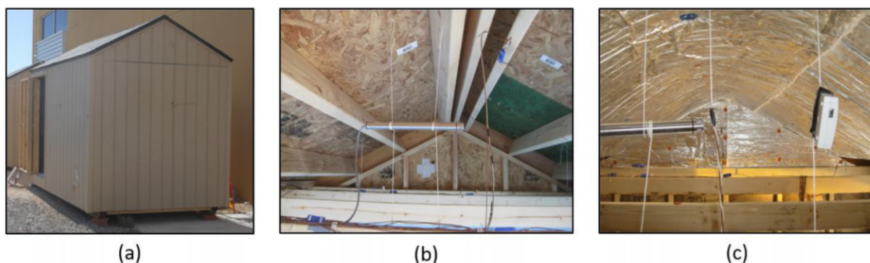
Figur 31: a) Testhytten fra utsiden, b) konvensjonell oppbygging av loftsrommet, c) laminert aerogel festet til takflaten på loftet [77].
