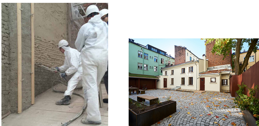
Figur 20: Aerogel i murpuss. Til venstre påføres murpussen på en fasade og til høyre illustreres en nylig rehabilitert murbygning [63].
