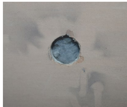
Figur 11: Aerogel som hulromsisolasjon blåst inn i veggen [45].
