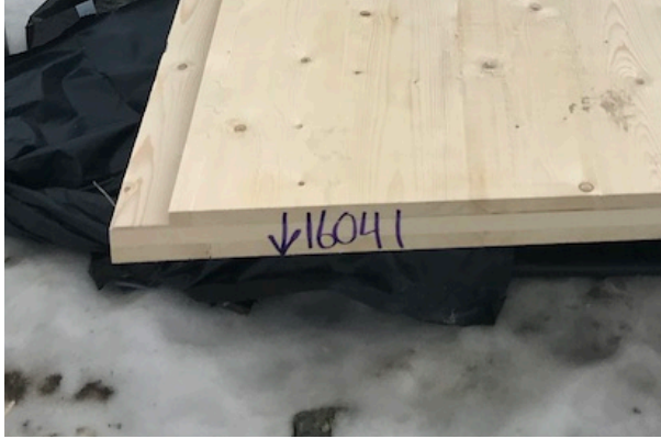
Figur 2 - Massivtreelement på Skjetlein vgs, 60mm, privat bilde
