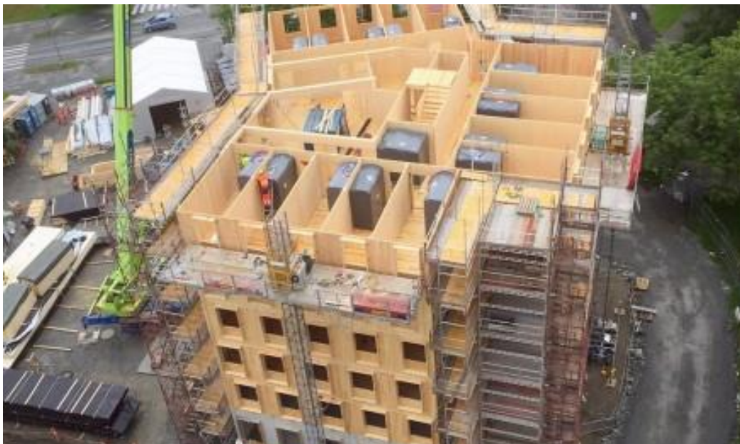
TRONDHEIM: I 2016 bygde Veidekke nye studentboliger på Moholt i massivtre. Foto: Veidekke.
