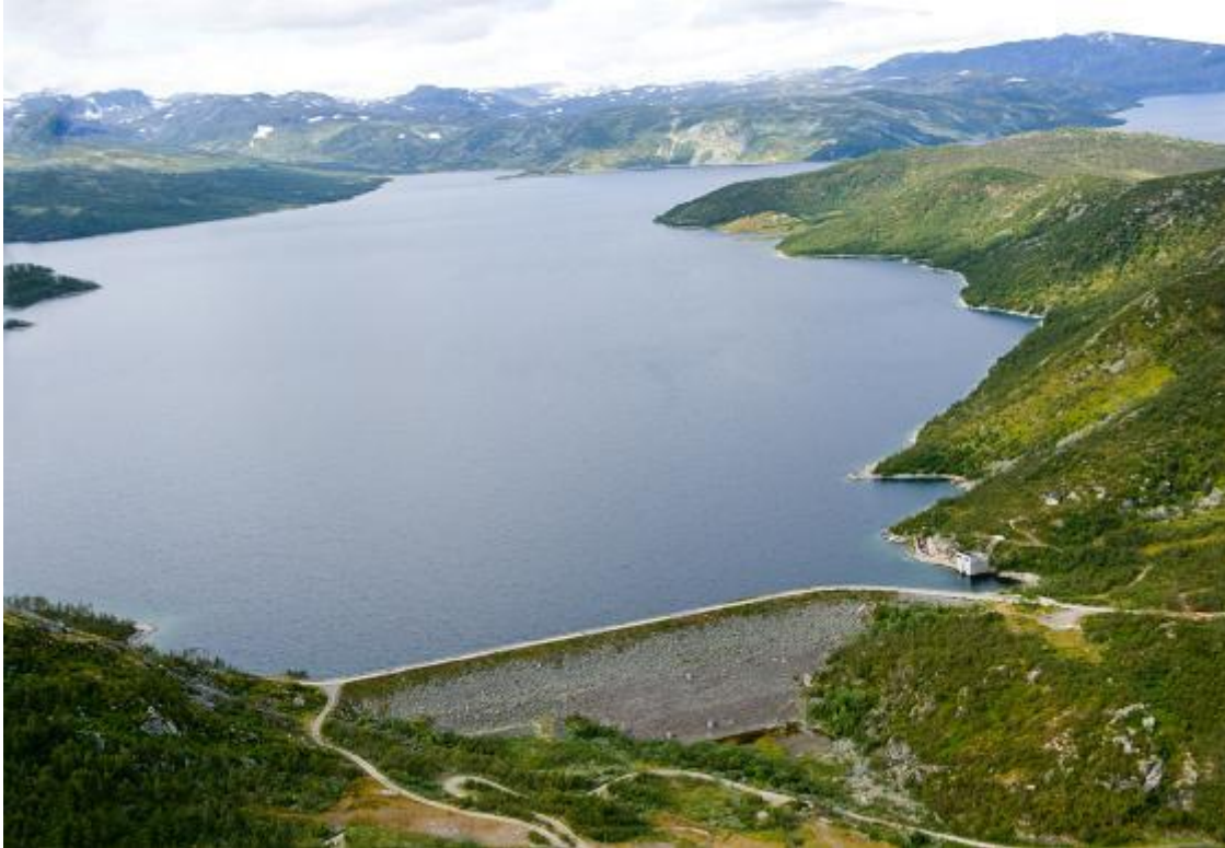
Figur 2 - Oversiktsbilde over dam Strandevatn.
