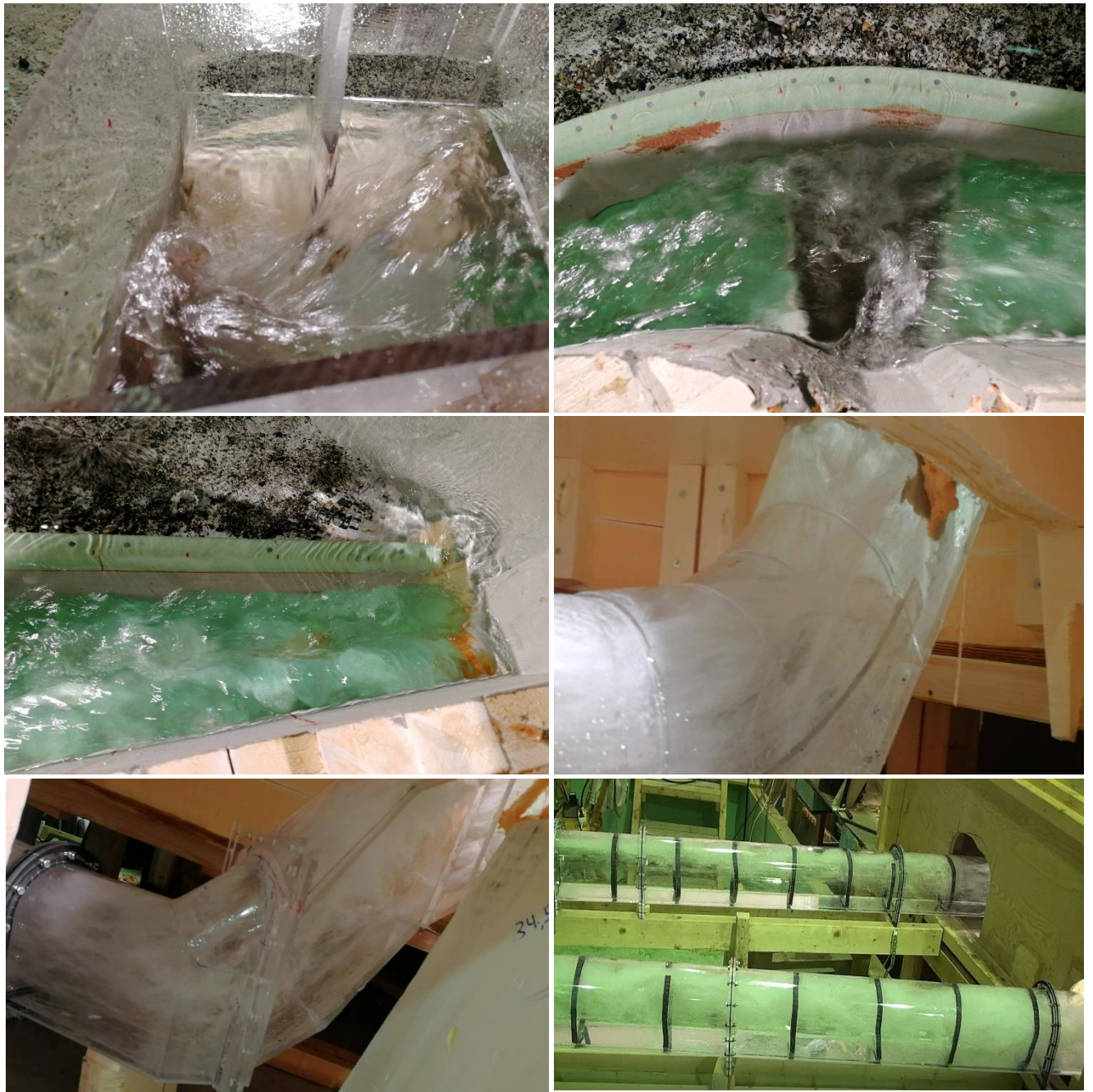
Figur 62 - Bilde av lukehus, sidekanal, ny og eksisterende sjakt og ny og eksisterende tunnel ved Q_{PMF} med begge lukene åpne.
