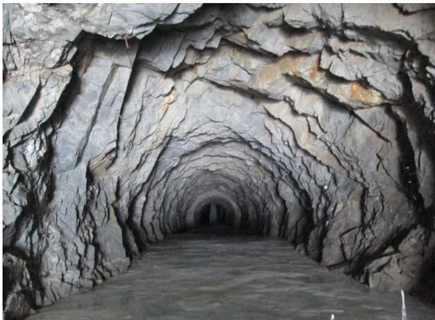
Figur 7 - Bilder fra befarings av flomløpet ved dam Strandevatn. Foto (Leif Lia, 2018)
