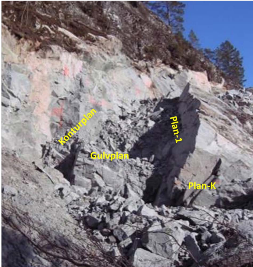
Figur 6 Kattmarka. Ugunstige sprekkeplan.
