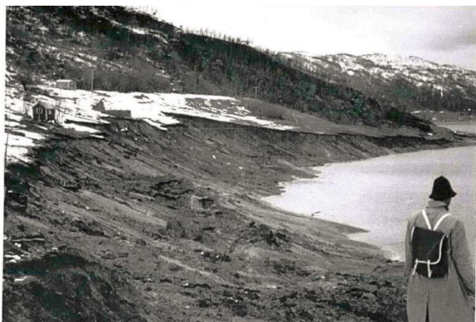
Figur 20 Skredet i Sokkelvik. Foto: NGI, 1959.
