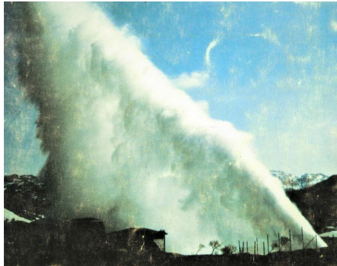
Figur 2-11 Utblåsing ved Holmaliåna (Bekkeinntakskomiteén, 1986).
