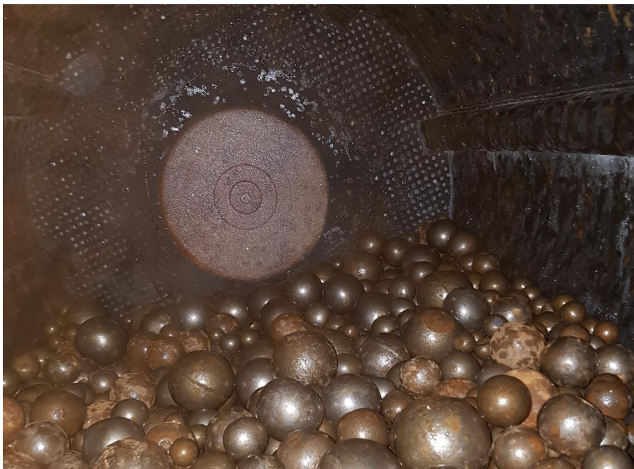
Figur 4-3: Innsiden av møllen etter kulene ble lagt inn.
