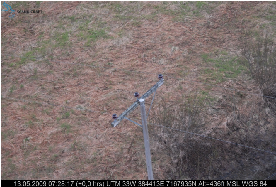
Figur 28, Observasjon 3, Mast - tretravers - råte
