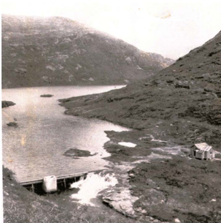
Figur 29 - Kvannevatn, damstedet slik det er idag. Sett mot nordvest (Søvgjarto, 2003).
