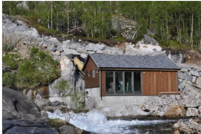
Figur 20: Kistafossen kraftverk med energiproduksjon på 5,5GWh [46]
