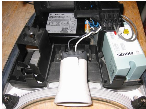
Figur 3.11 Philips HID-Dynavision elektronisk forkobling
