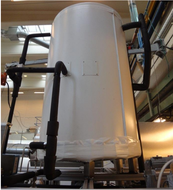
Figur A-2 Ny varmeveksler på generatorkretsen. Lengde: 2*30 m
