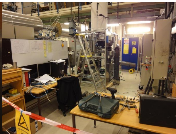
Figur A-14 Varselsskilt og avstgning av området ble utført under trykktesting
