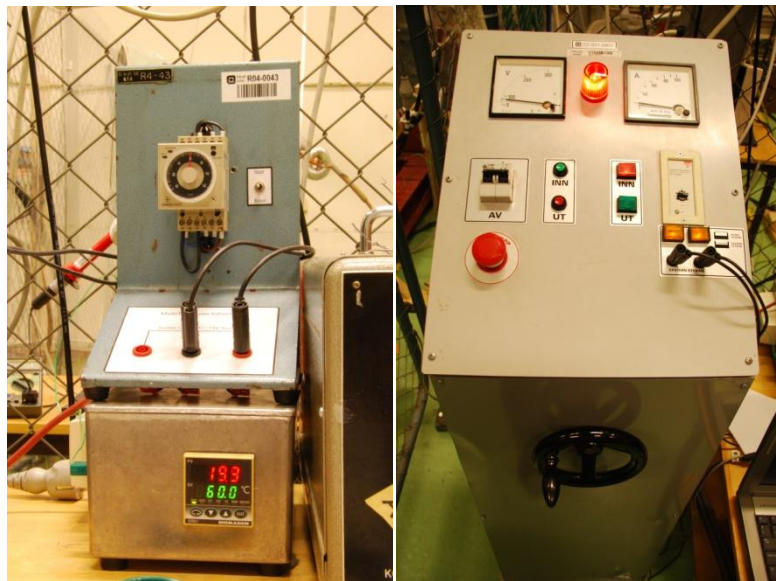
Figur 3.6: PID-regulatoren til temperaturstyringen (nederst til venstre), tidsbryteren til strømstyringen (øverst til venstre) og styringspulten til strømreguleringen (til høyre).
