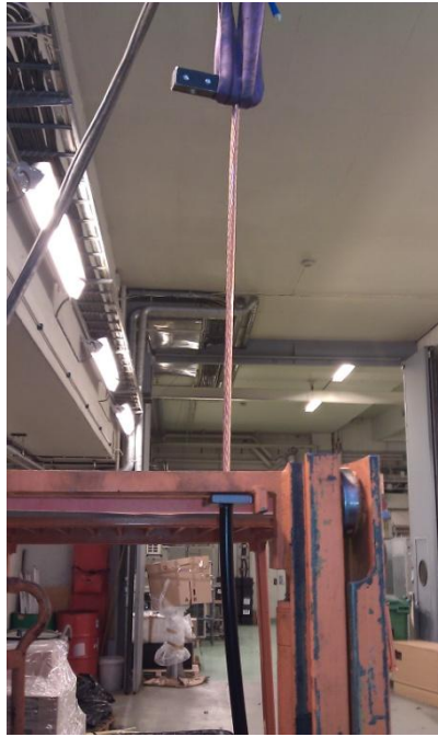
Figur 3.30: Prosessen hvor lederen trekkes ut av isolasjonen.
