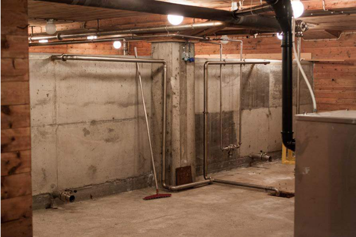
I kjelleren under utsalgslokalet finner en to gamle saltkar i betong. De har vært brukt til osteproduksjon. Det er ikke utenkelig at disse kan tas i bruk igjen til matproduksjon eller brygging.
