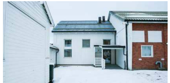
Noen detaljer fra bygningen. Murveggen viser bare løpere, så en ser at tegl ikke er det bærende materialet.
