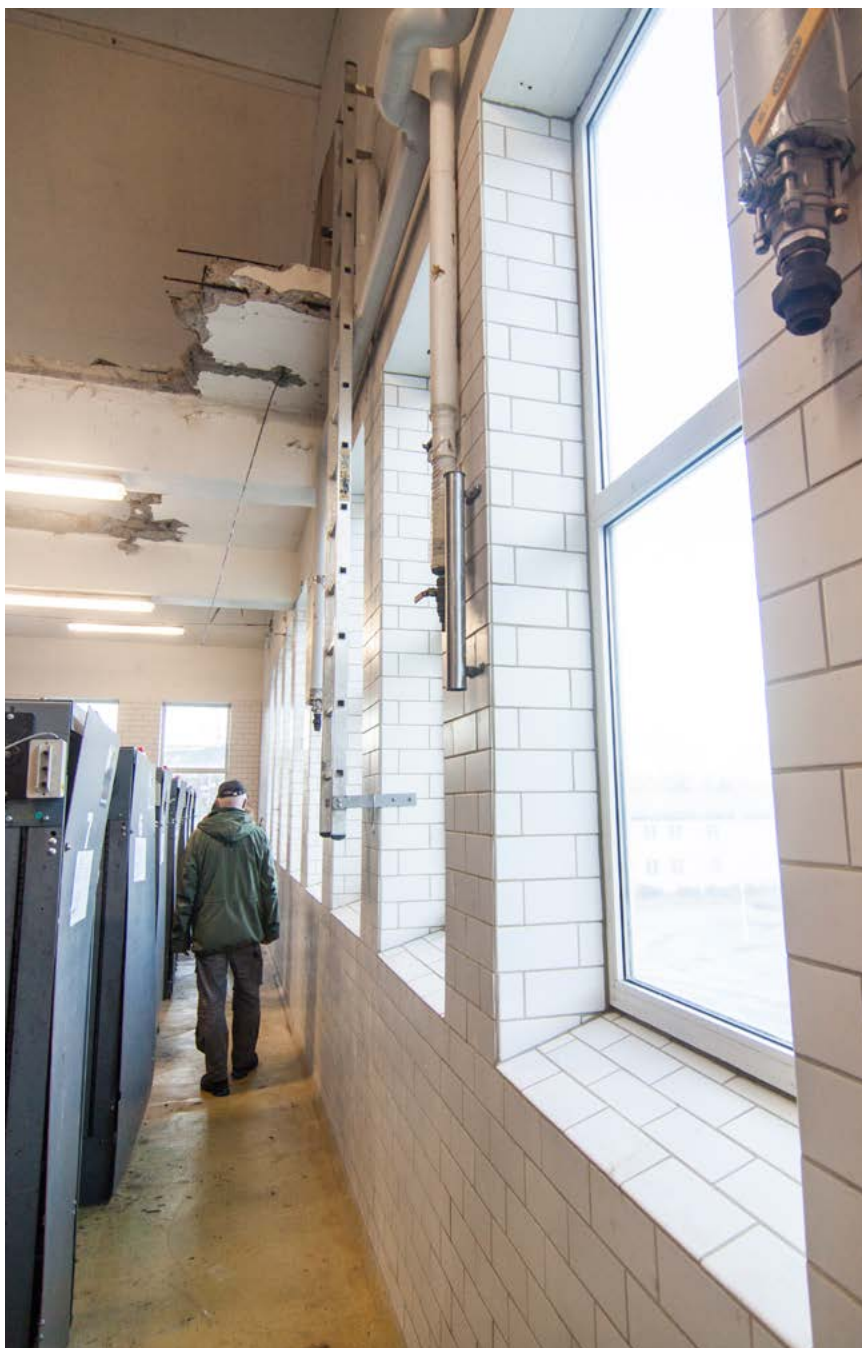
Endevegg ut mot nord viser de store vinduene. Rommet er i dag maskinrom for bowling.
