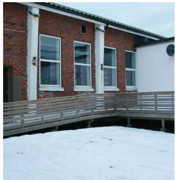
Noen detaljer fra bygningen. Murveggen viser bare løpere, så en ser at tegl ikke er det bærende materialet.
