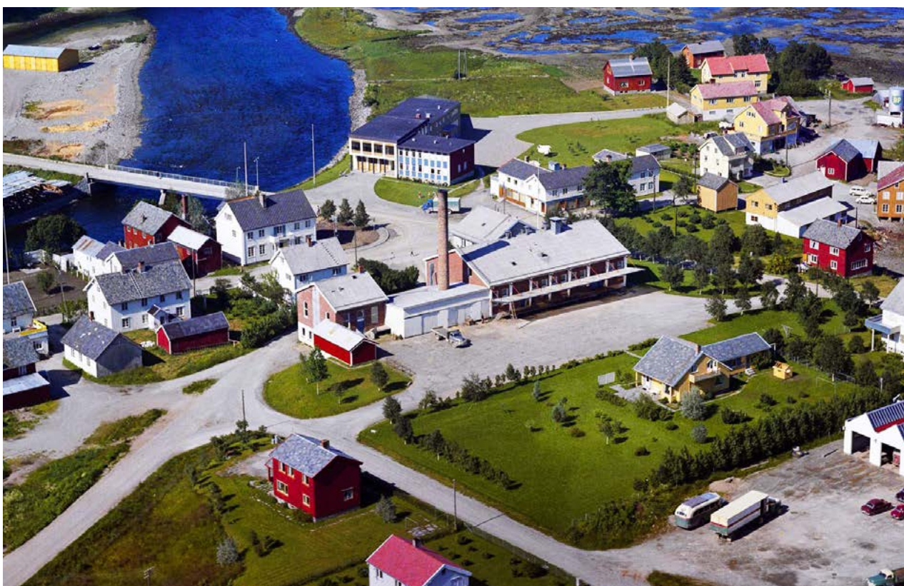
Meieriet før ombyggingen av fyrhuset i 1964.
