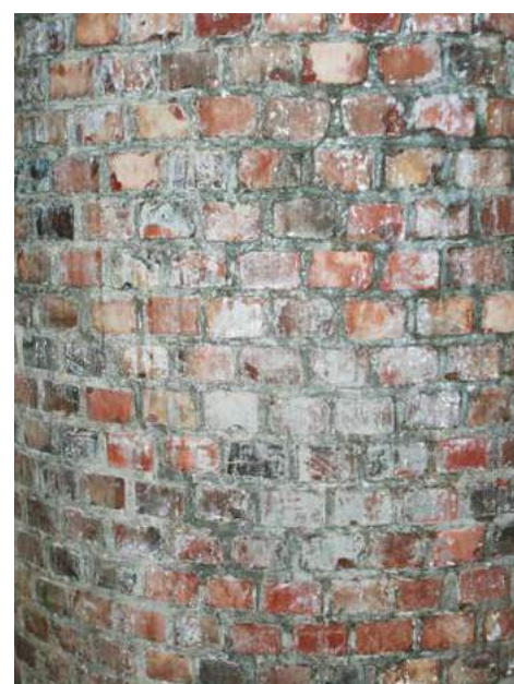
Detaljer av pipa på innsiden.
