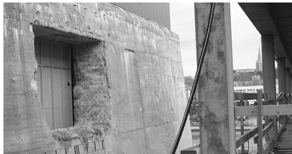
Hullet i vegg etter man prøvde å sprengte bunkeren
