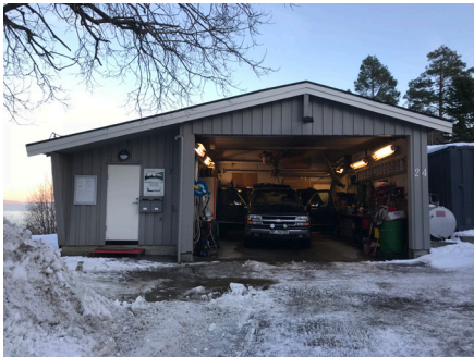
Borettslaghus og vaktmesterkontor
