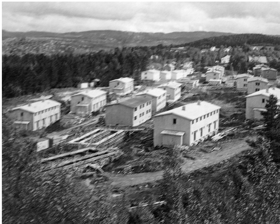
1: Fagerlia 1954, under bygging. Fagerlia Hageby Borettslag er et eksempel på den sosiale boligbyggingen fra etterkrigstiden.
