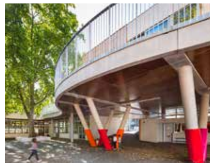
Klaring mellom bygg og tak
