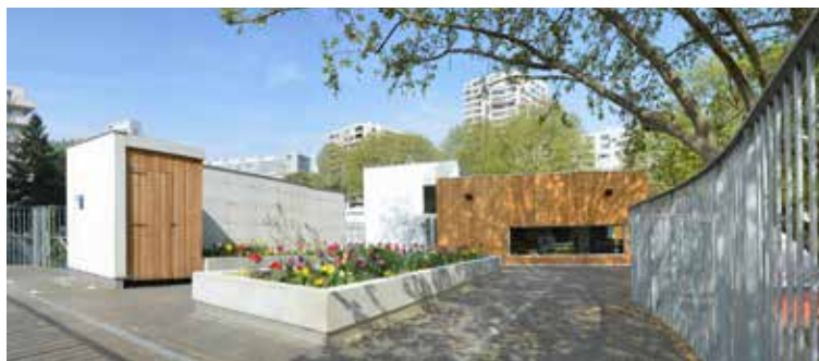
Tak i betong med et asfaltlag
