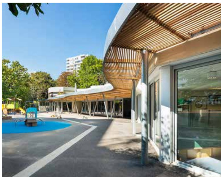
Måter å få en rund bevegelse på tak, uten samme form på bakkeplan. Fotograf: Sergio Grazia
