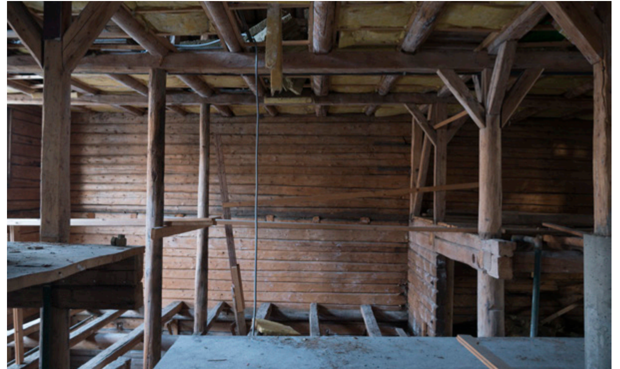
Søyle- og dragerkonstruksjon Kjøpmannsgata 15
