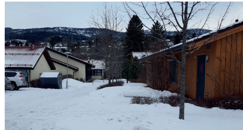
Dagsenteret og FIDES-bygget til venstre, boenheten Lyngen til høyre i bildet.
