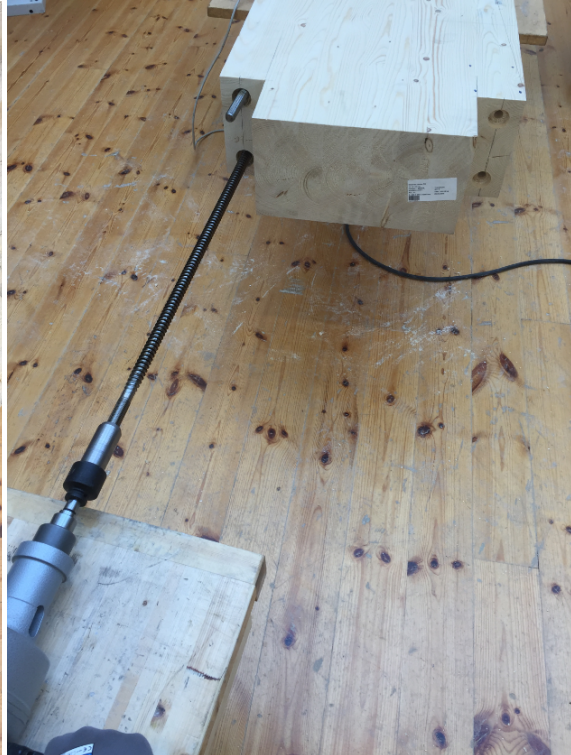
(b) Innskruing av gjengestenger
