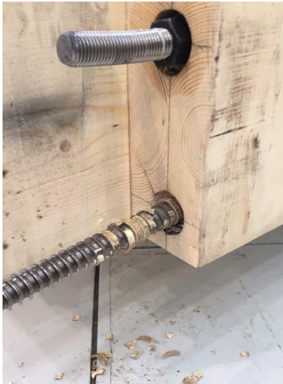
(a) Utskruing av gjengestangen
