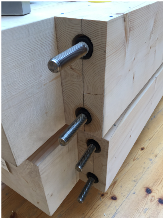
(a) Montering av muttere med gjengeteip
