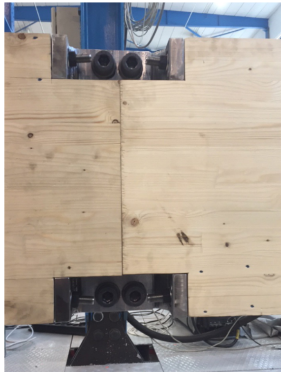
(d) Ferdig montert skjøt
