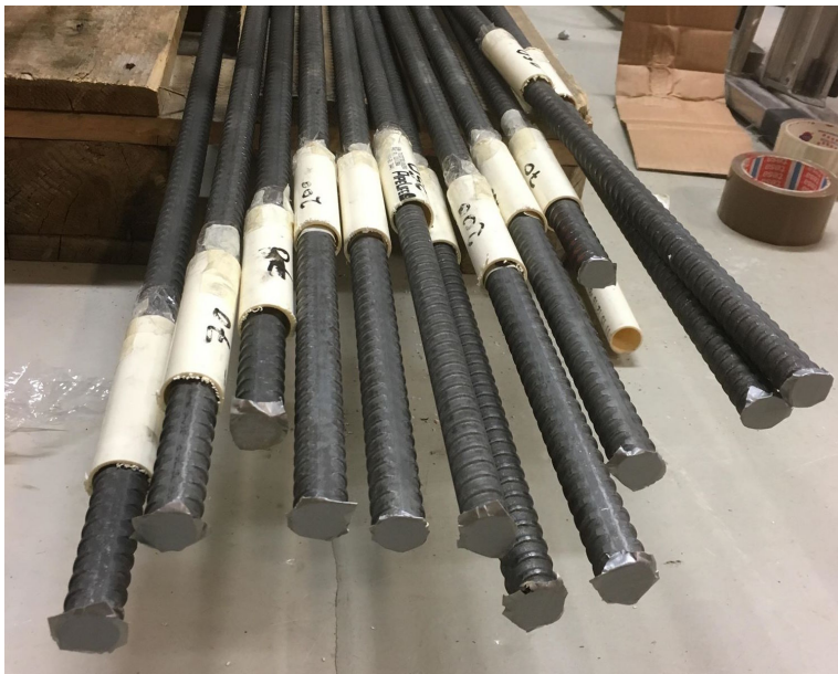
Figur 5.6: Beskyttelsesrør og teipbit på enden av stålstaget
