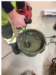
Figur 5.10: Blanding av sementmørtel
