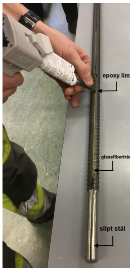
(a) Installasjon av tøyningssensorene
