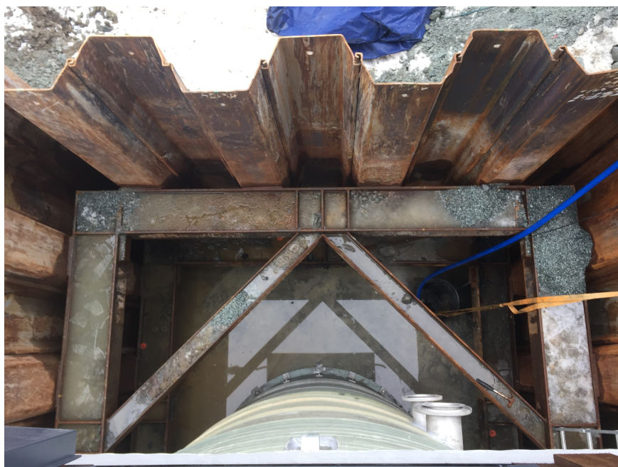
Figur 5.3: Detaljert oversikt over avstivingsystem
