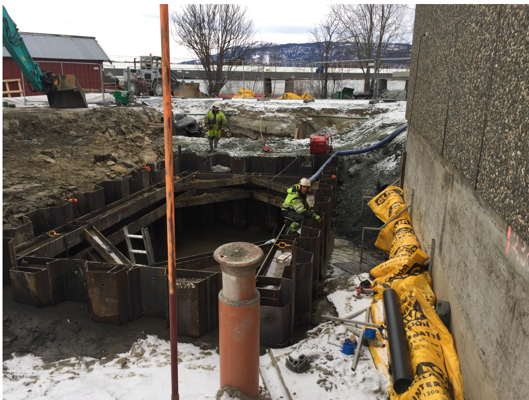
Figur 1.1: Spuntgrop på Hell
