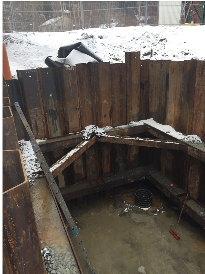
Figur 5.2: Spuntgrop med innvendig avstiving
