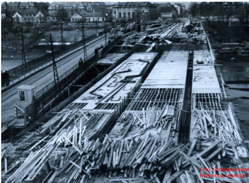
Figur 4.3: Bilde av forskaling under bygging
