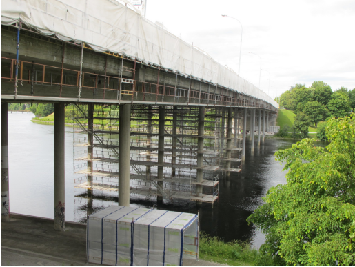
Figur 3.13: Rehabilitering av søyler [4]
