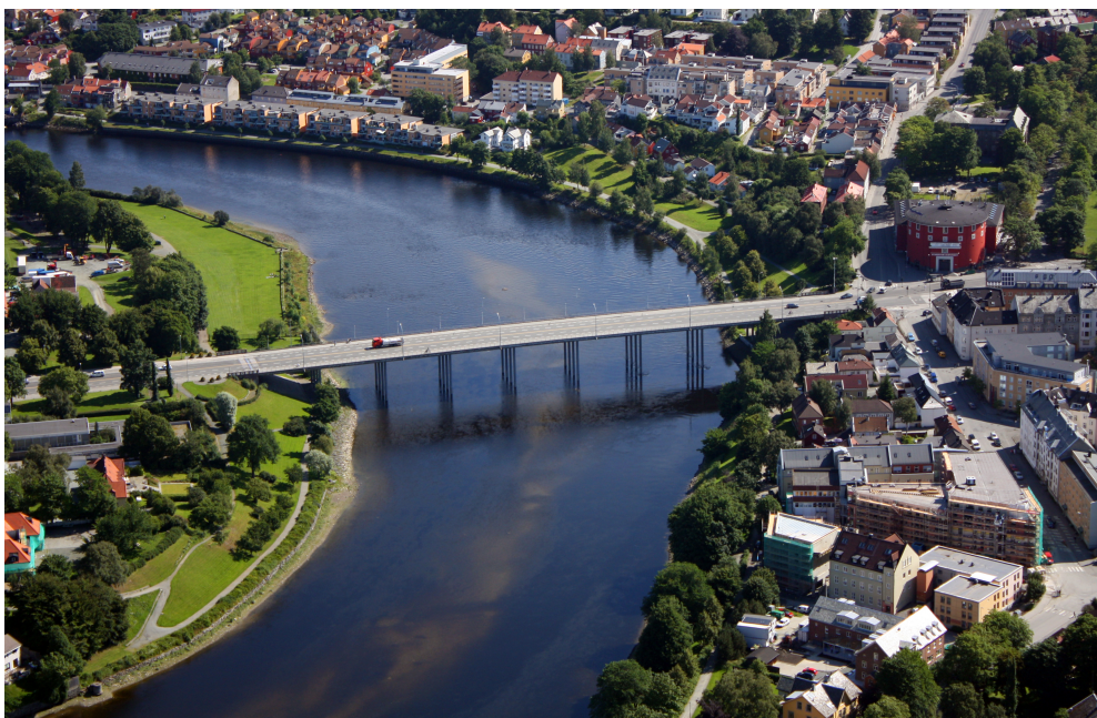
Figur 3.1: Elgeseter bru sett fra vest
