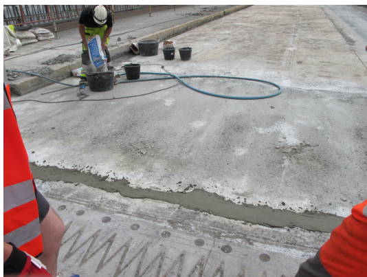
Figur 3.8: Brudekket ved fugen etter reparasjon [3]
