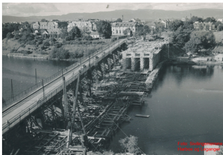
Figur 3.3: Elgeseter bru under bygging side om side med den gamle brua. "Ingeniørkunst fra hver sin tid" [25]
