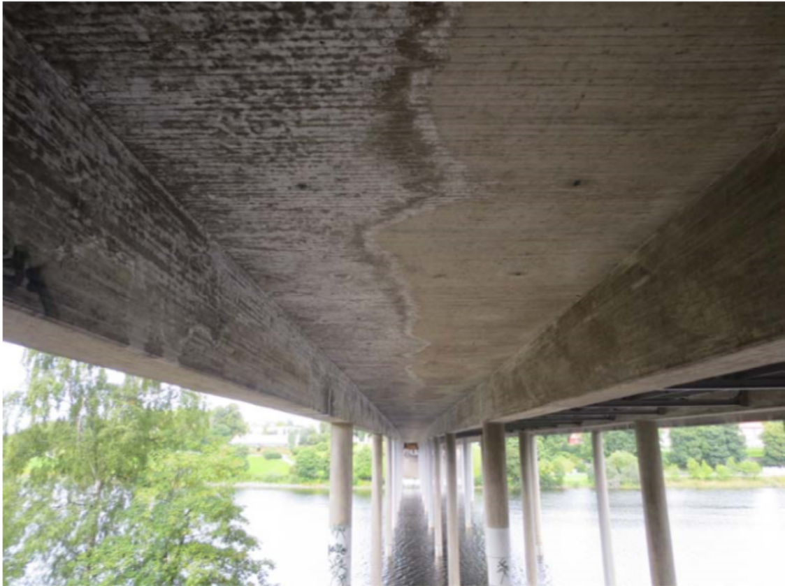
Figur 3.18: Underside av brudekket [16]
