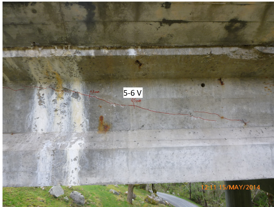
Figur 4.4: Gjennomgående skråriss i NIB-bejelke akse 5-6 mot vest.
