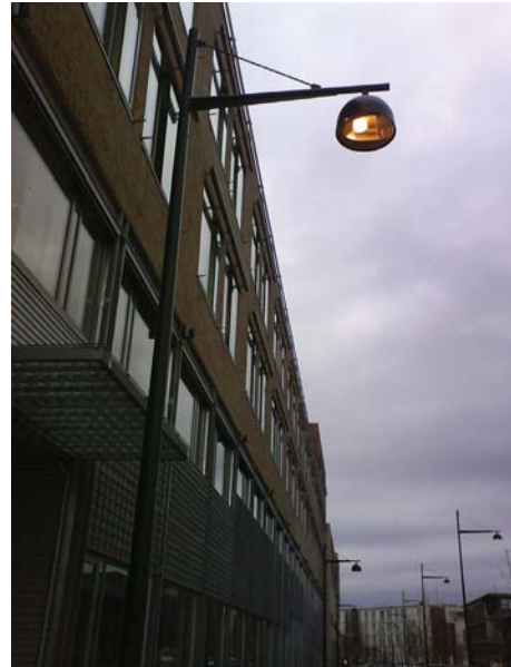
Figur 5.18: Mast med induksjonslampe [55 W] ved St. Olavs hospital
