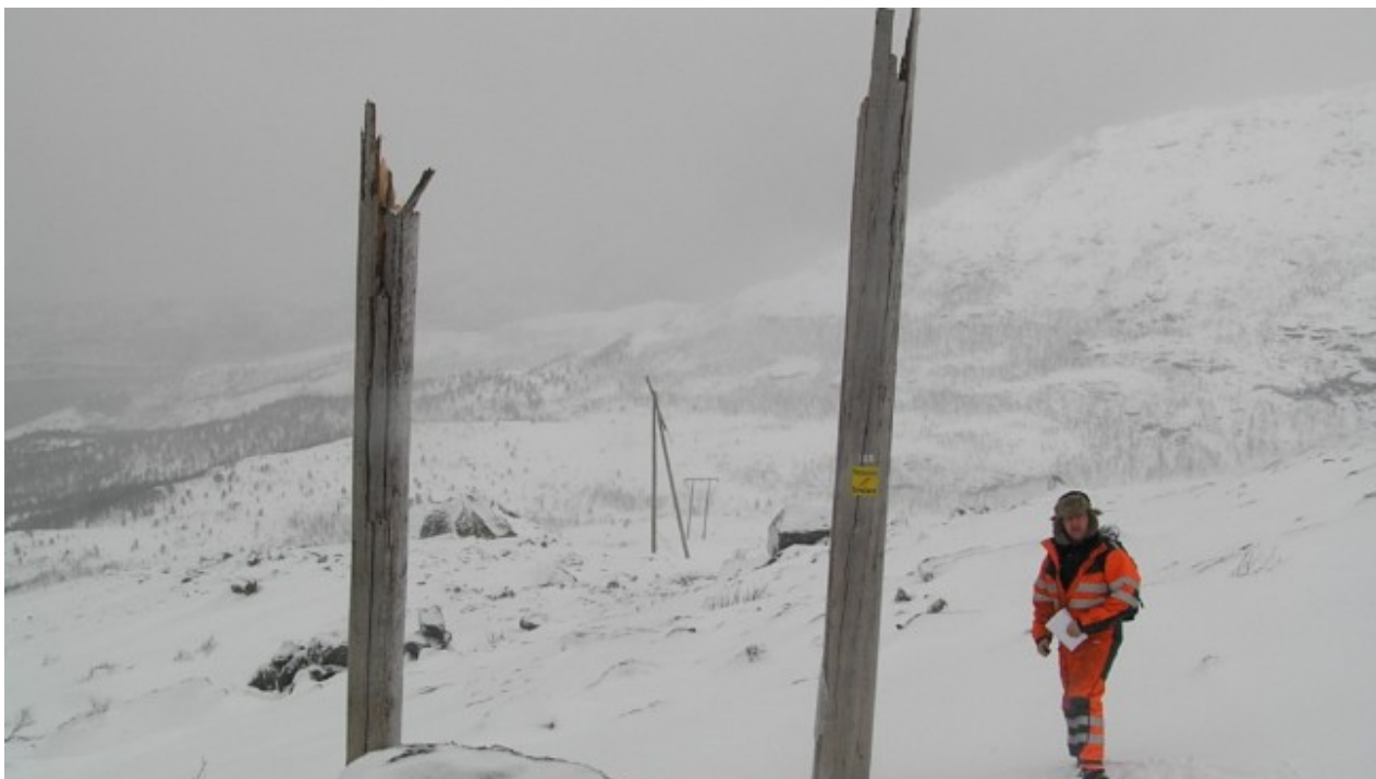
Bilde 1 Hoveforsyningen inn til Steigen i etterkant av uværet i slutten av januar 2007 [14]
