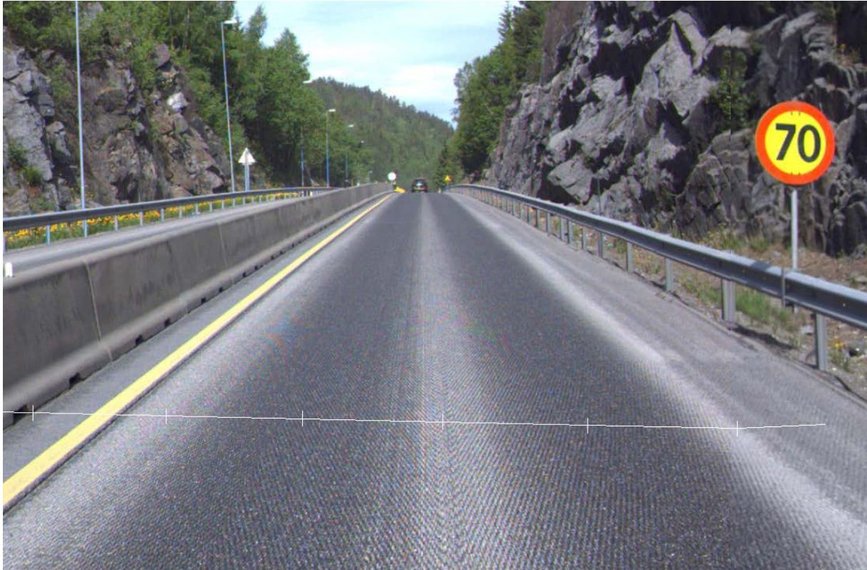
Bilde 4.3 Vegarbeid i området ved målepunkt 800010 sommeren 2017 (hentet fra Statens vegvesens vegbilder)
