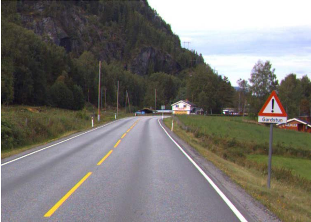
Bilde 4.1 Situasjonen ved målepunkt 642999 som ligger 2-300 meter etter dette skiltet (hentet fra Statens vegvesens vegbilder)
