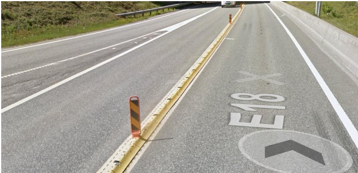
Figur 5.6.5: Illustrasjon av forhøyet oppmerking med refleks (Google Maps 1 )
