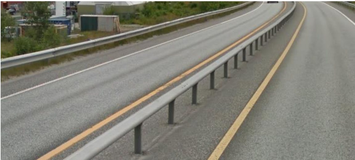
Figur 5.6.8: Illustrasjon av midtrekkverk (Google Maps 3 )
