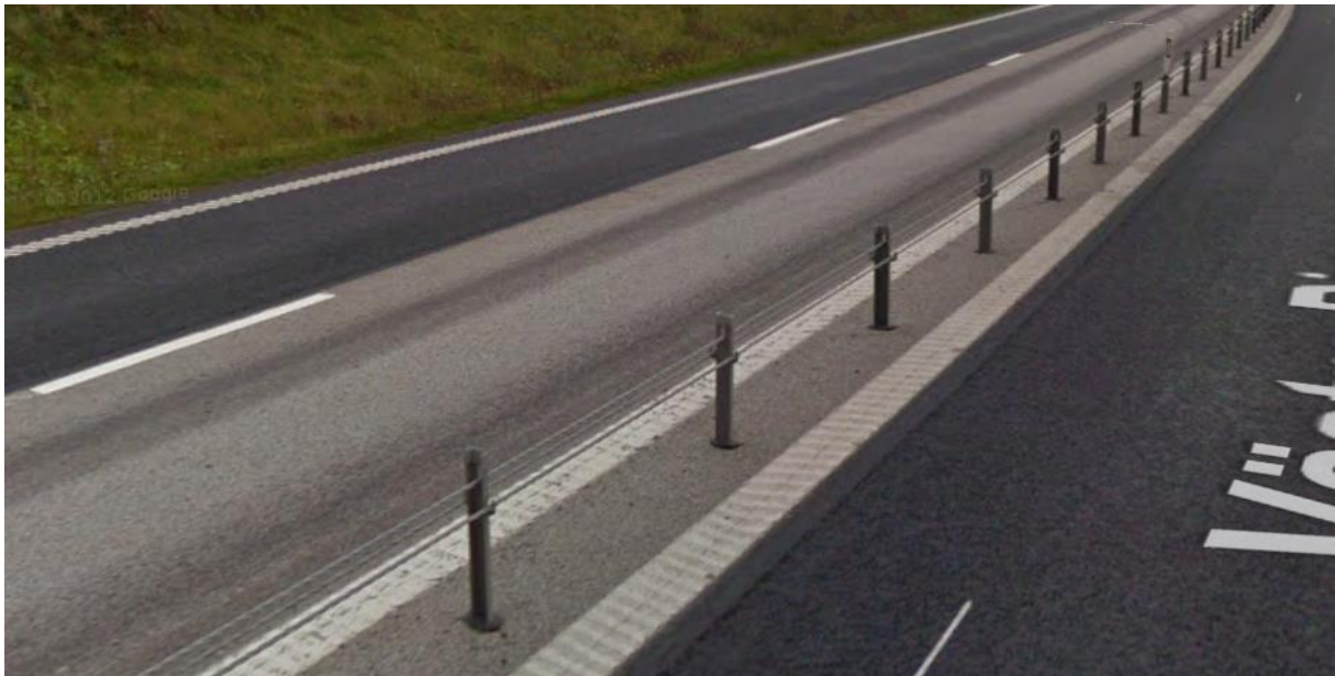
Figur 5.6.7: Illustrasjon av vaier-rekkverk (Google Maps 2 )
