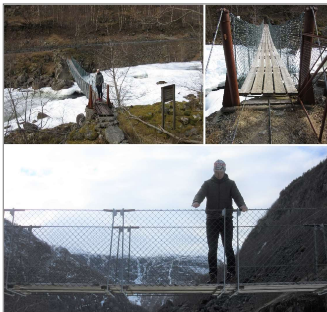
Figur 2.11: Egne bilder fra befarings i Måbødalen
