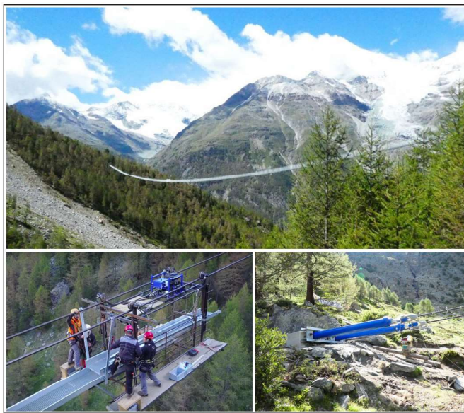
Figur 2.12: Charles Kuonen Suspension bridge. Montasje og dempersystem [21]
