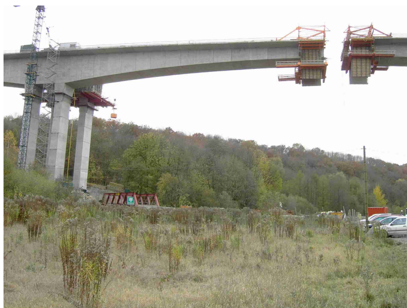
Figur 2.1: FFB-bru rett før sammenkobling (Störfix, 2005)
