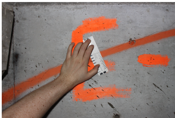
Figur 5.13: Skråriss ca. 15 m fra F mot E
