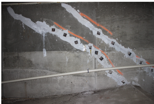
Figur 5.5: Injiserte skjærriss fra akse A mot B
