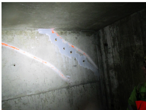
Figur 5.6: Riss rundt akse C (Aas-Jakobsen, 2014)
