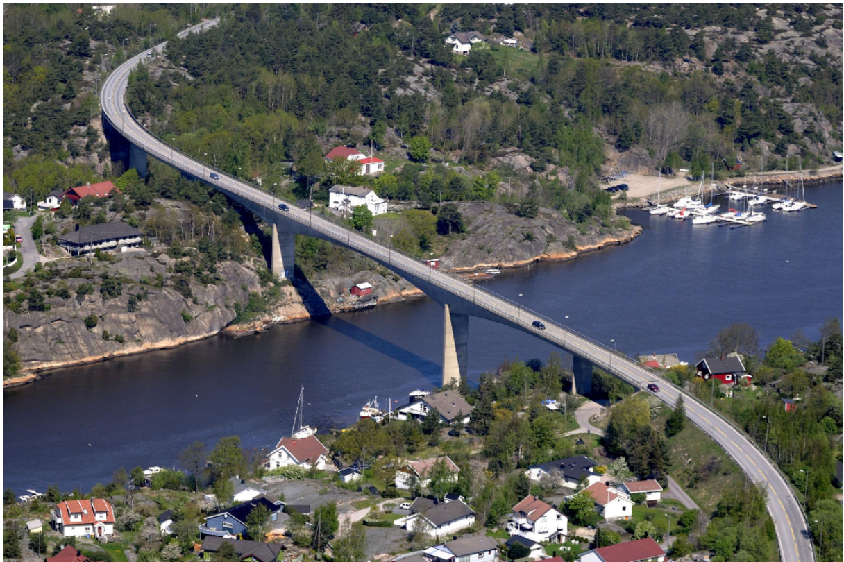
Figur 4.1: Kjøkøysund bru (Hagen, u.å.)
