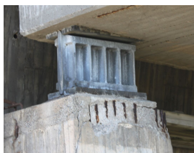
(c) Armeringskorrosjon
