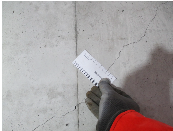
Figur 5.12: Skråriss 10-15 m fra søyle E ut i hovedspennet DE (Aas-Jakobsen, 2014)
