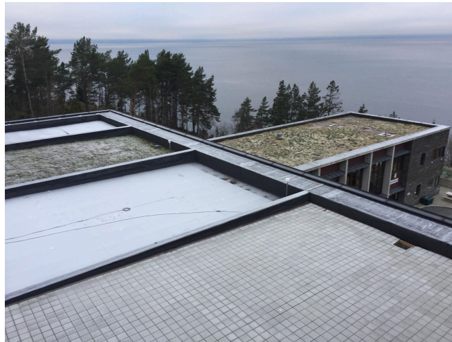
Figur 1: Mye forskning blir gjort både i laboratoriet og i felt. Her testes ulike fordrøyningsbaserte tak i fullskala for et kaldt og vått klima. Foto: Lotte Askeland Schärer
