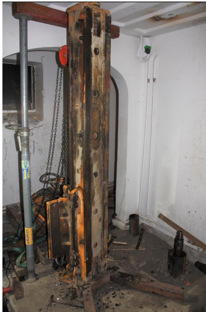
Figur 11: Refundamenteringsarbeid i kjelleren av Sysselmansboligen fra 2017 (Foto: M. Haugan)
