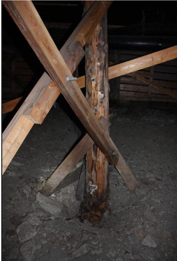
Figur 13: Eksempel på råteskadet pelefundament i Longyearbyen (ikke fra Spisshus) (Foto: M. Haugan)
