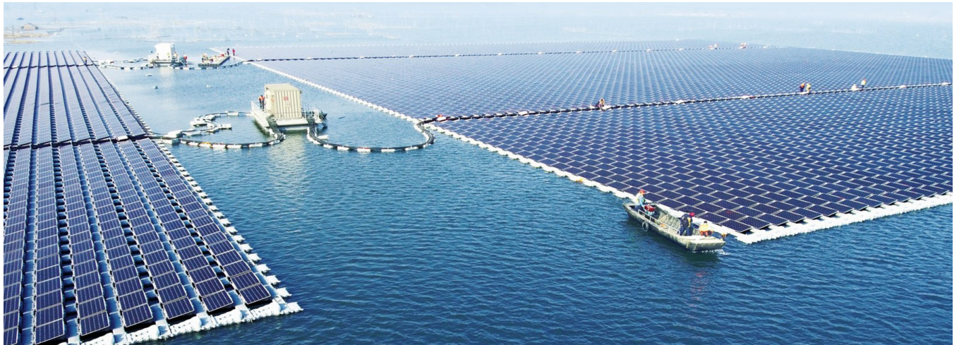
Figur 2.5: Det 40 megawatt-store flytende kraftverket i Huainan i Kina, SUNGROW[6]
