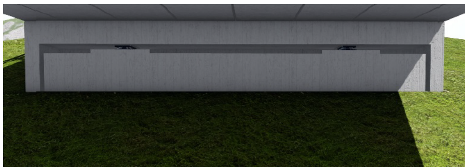
Figur 12: Opplegg på prefabrikkert betongbru. Hentet fra SVV.
