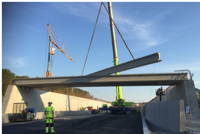
Figur 22: Montasje av bjelkeelementer [30]
